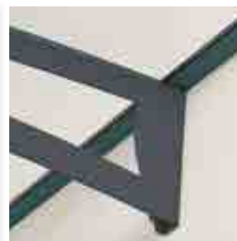
Horganyzott és lakkozott acél merevítők
