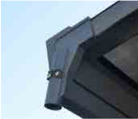
Minden sarkában beépített vízvezető csatorna van.
